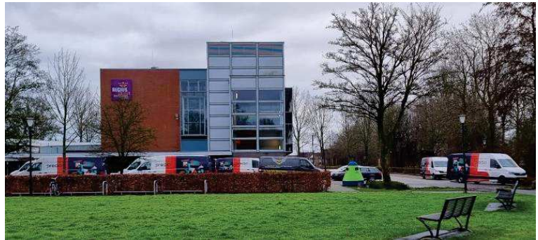
De leverancier werkt aan plaatsing digiborden
