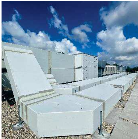
Dak Oranjelaan met nieuwe installatie
